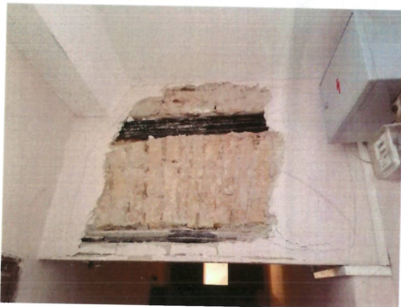
Slika 5-7 Sondažna bušotina 6 – Zidani luk - opeka „starog formata“
