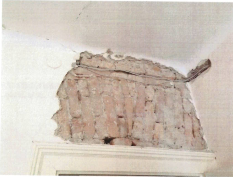
Slika 5-19 Sondažna bušotina 15 – Zidani lučni nadvoj - opeka „starog formata“
