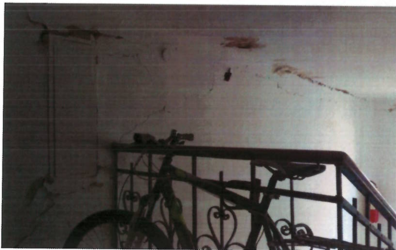
Slika 4-9 Pukotine u stubišnom zidu u potkrovlju i na spoju s krovnom konstrukcijom
