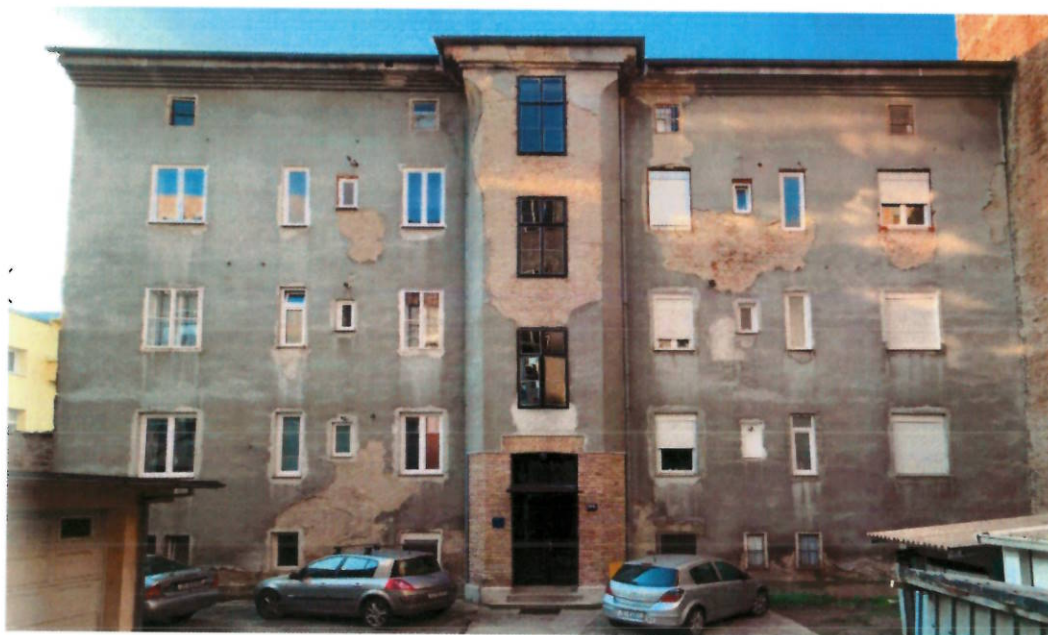
Slika 3. 2 Prikaz sjevernog pročelja građevine
