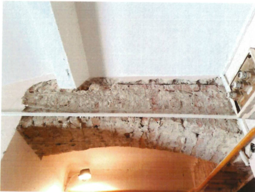
Slika 5-20 Sondažna bušotina 16 – Zidani luk - opeka „starog formata“
