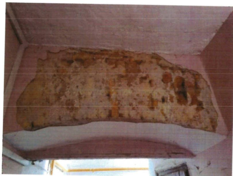
Slika 5-8 Sondažna bušotina 6 – Zidani luk - opeka „starog formata“
