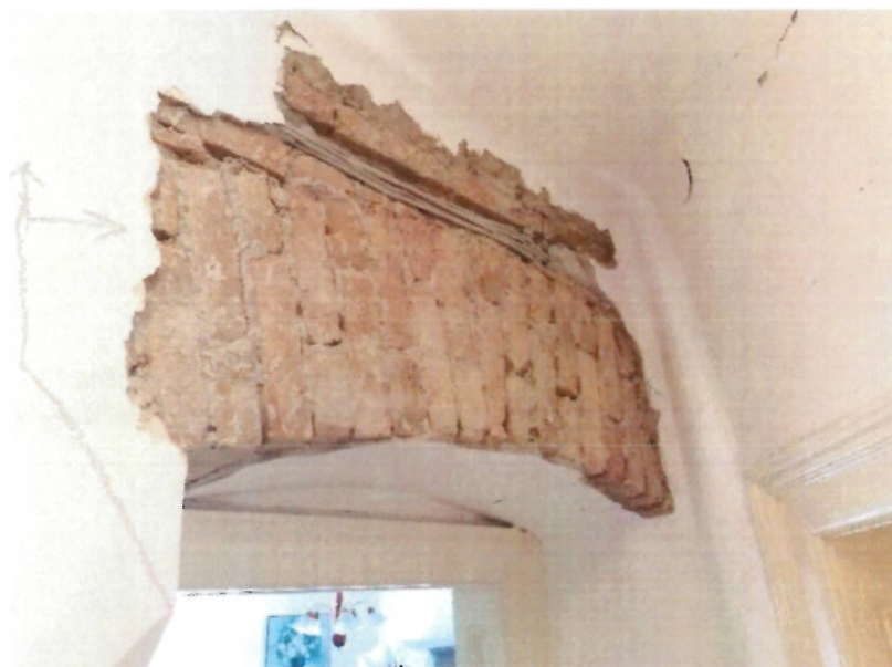
Slika 5-18 Sondažna bušotina 15 – Zidani lučni nadvoj - opeka „starog formata“
