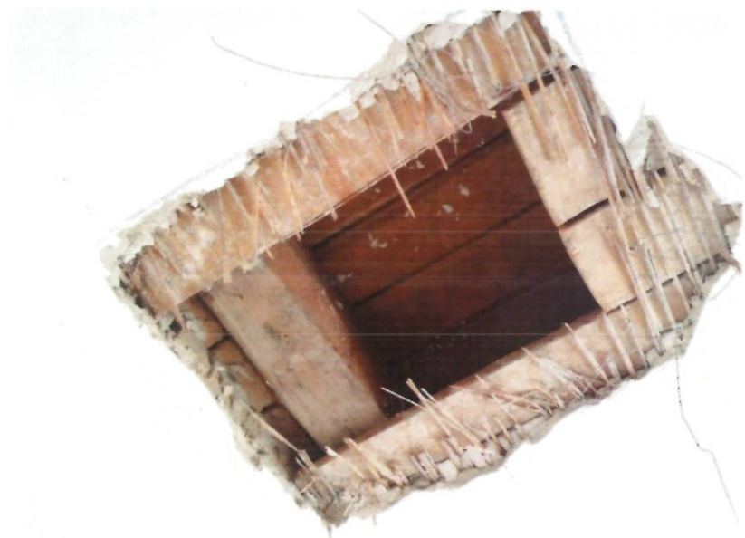
Slika 5-16 Sondažna bušotina 13 – Drveni grednik; poprečni zid između stanova kontinuiran
