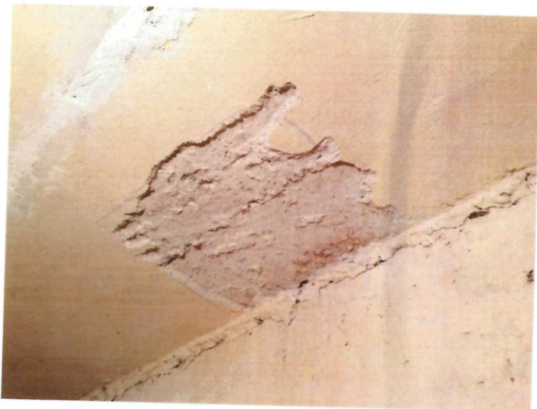
Slika 5-3 Sondažna bušotina 2 – Armiranobetonska stropna ploča podruma
