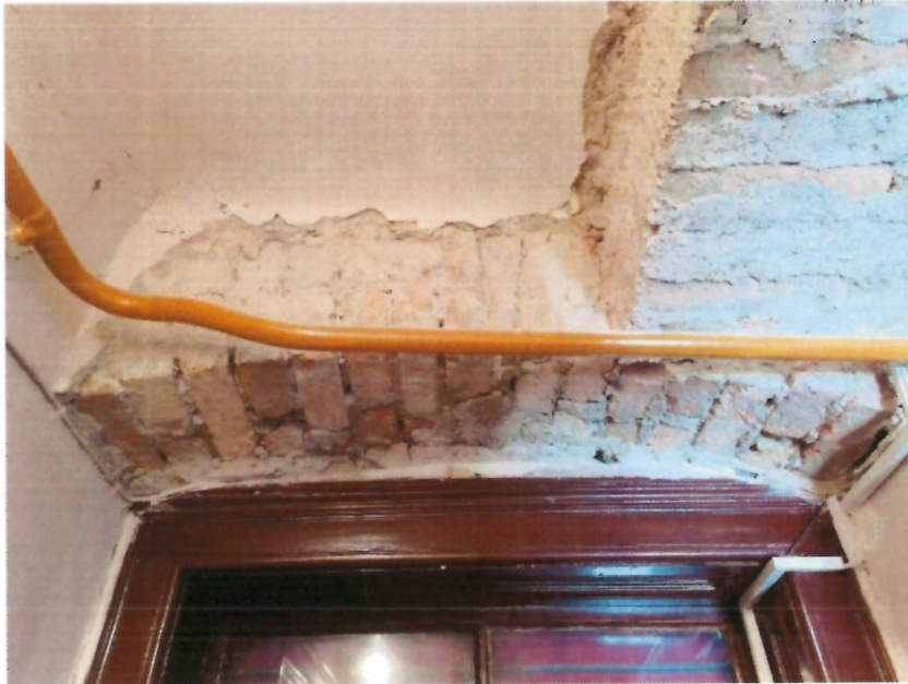
Slika 5-21 Sondažna bušotina 17 – Zidani lučni nadvoj - opeka „starog formata“
