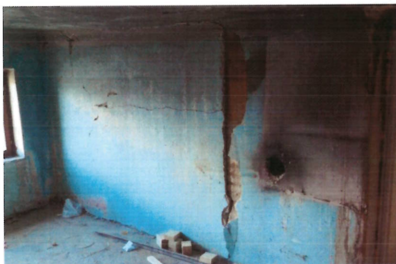
Slika 4-7 Pregradni zid u potkrovlju odvojen od dimnjaka
